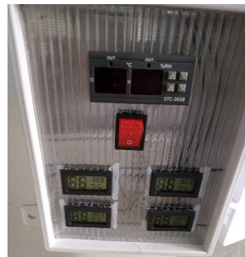
ภาพที่ 9 กล่องควบคุมระบบพลังงานแสงอาทิตย์
