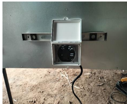
ภาพที่ 7 การติดตั้งฮีตเตอร์
